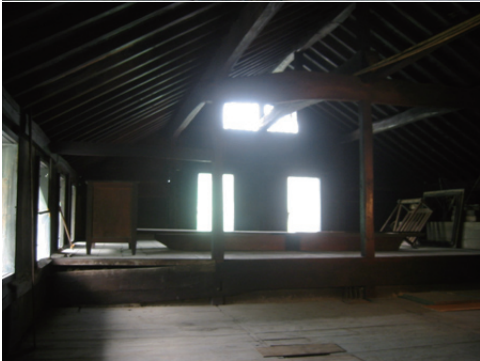
2階段差ユア床鉋仕上げ舞台
