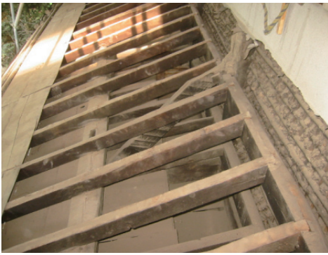
玄関上部吊木 方杖(柱より吊 り込む)
