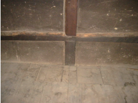
2階北壁際引き戸、下部は寝室納戸（箱階段）の間
