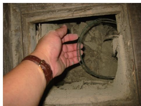
貴人口8畳一北側、炉土壁、配管吊金物
