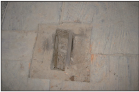
小屋束痕跡（床板の切り込み跡）主屋2階五の二部
