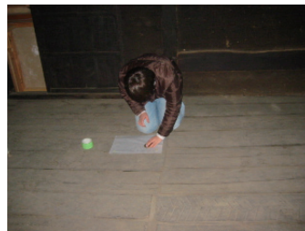
主屋 2 階式の式～沓間床板拓本撮り 床板曳き目拓本（慶応元年 1865）
