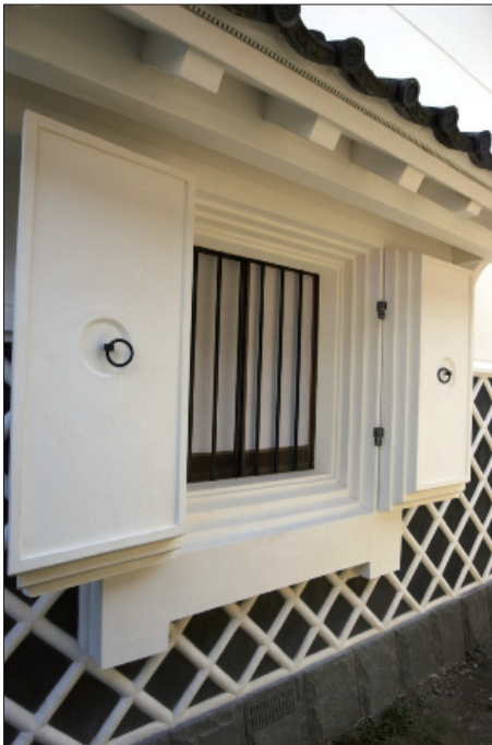
曳き屋・修復後
