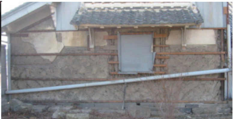
修復前・商家蔵北、海鼠壁痕跡
