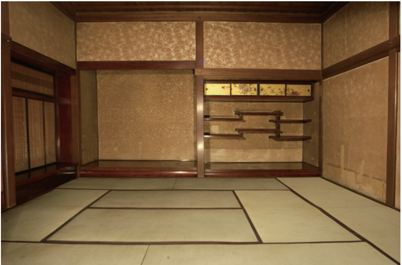
主屋奥座敷 10 畳・壁修復後
