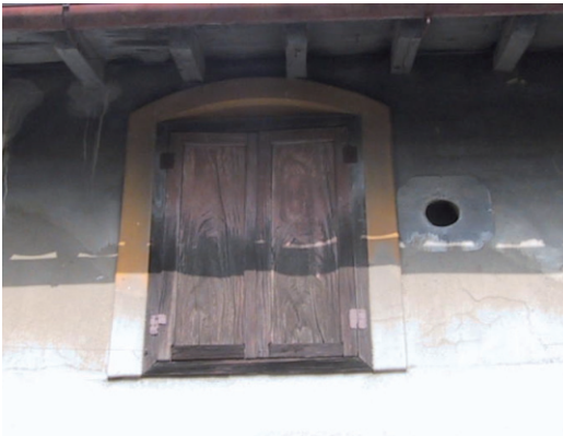
修復前・主屋2階アーチ枠・窓（木目描き痕跡）
