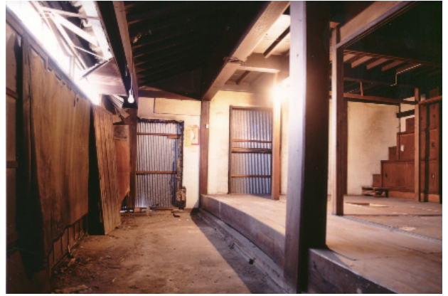
修復前・商家蔵土間
