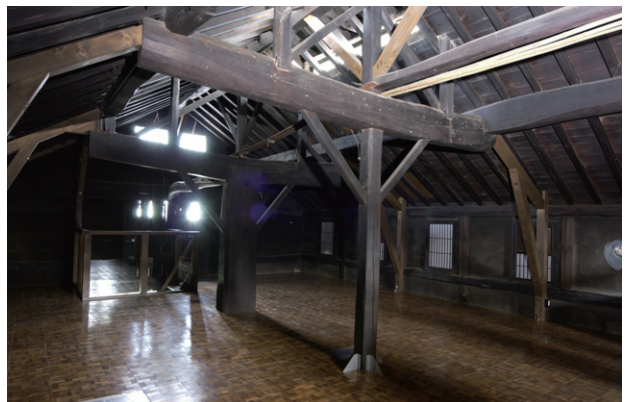
主屋2階・耐震補強
